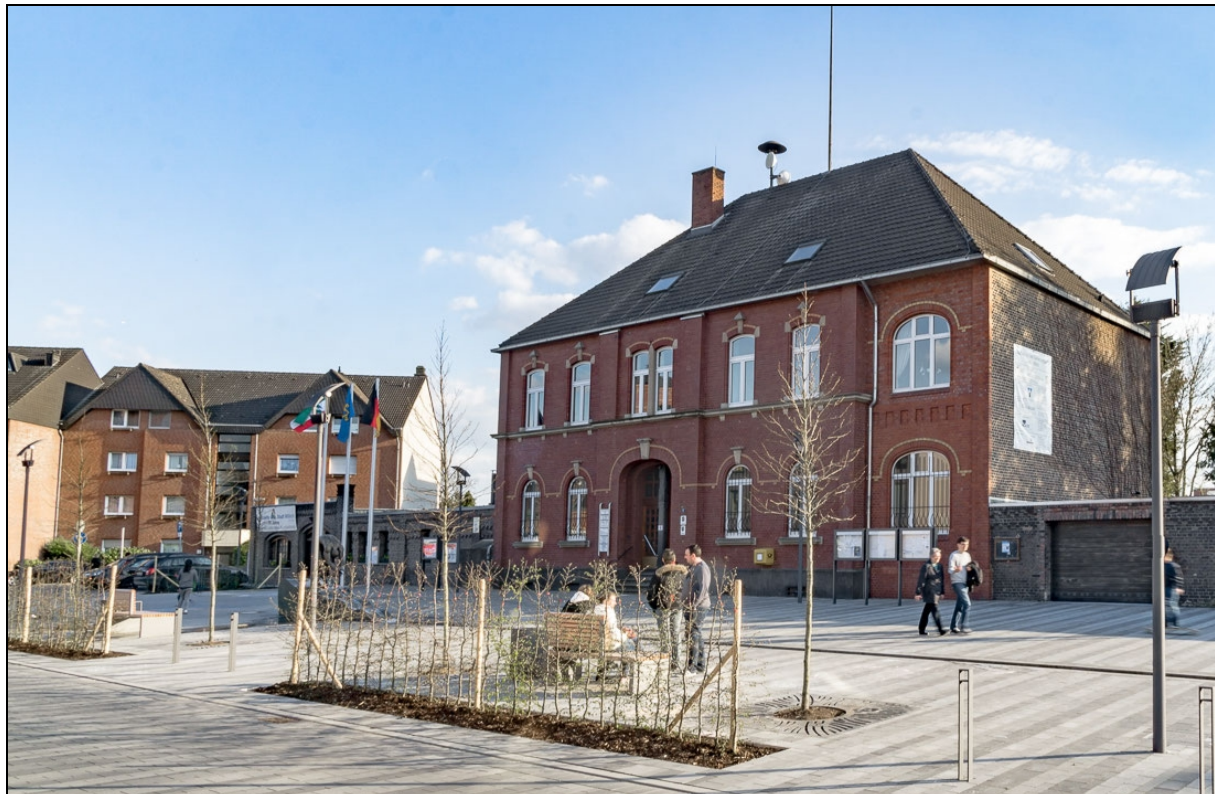
Abbildung 27: Kaiserplatz nach dem Umbau
