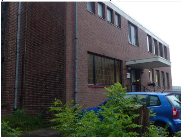
Abbildung 5: Krefelder Straße 354a (Quelle: Aufnahme vom 01.07.2020)
