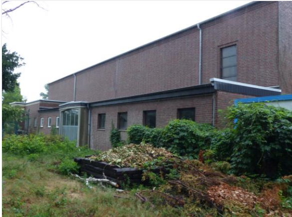
Abbildung 3: Rückansicht des ehem. Kirchengebäudes (Quelle: Aufnahme vom 01.07.2020)
