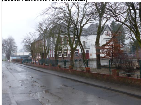
Abbildung 7: Blick Richtung Osten auf Schule Willicher Heide (Quelle: Aufnahme vom 02.02.2021)
