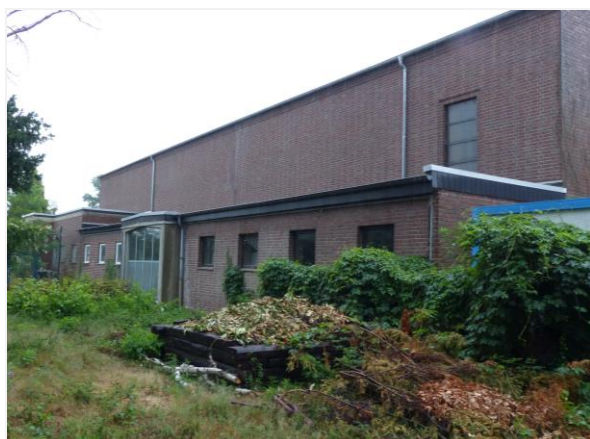
Abbildung 4: Rückansicht des ehem. Kirchengebäudes (Quelle: Aufnahme vom 01.07.2020)
