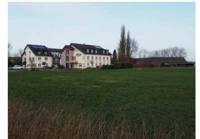
BLICK AUF GÄSTEHAUS BRANGSHOF
