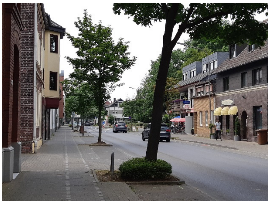
Hochstraße, Höhe Zehnthofstraße Richtung Kurt-Schumacher-Park
