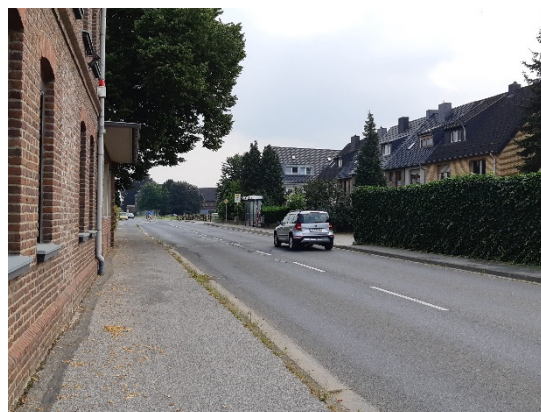
Ortslage Niederheide, Geh- und Radweg im Zweirichtungsverkehr, Engstelle
