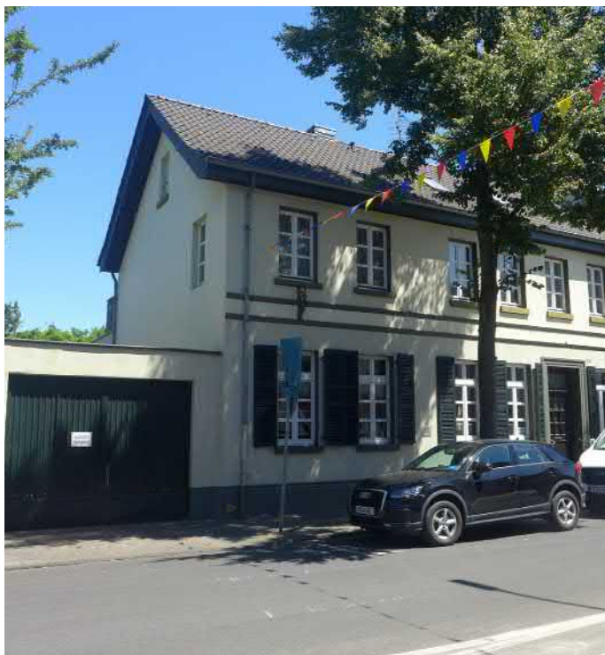
Abb. 5: Denkmalgeschütztes Wohngebäude an der Bahnstraße (scheuven+wachten plus)
